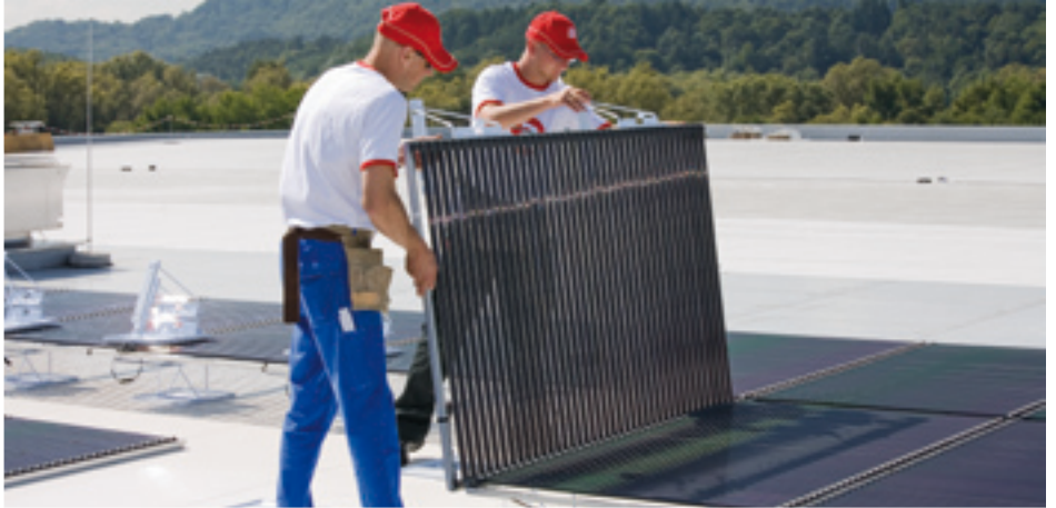
▲ Snelle en eenvoudige installatie zonder dakpenetratie
